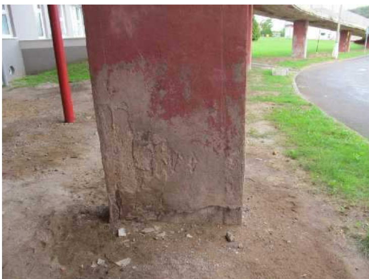
Degradace betonu pilíře Pi6.
