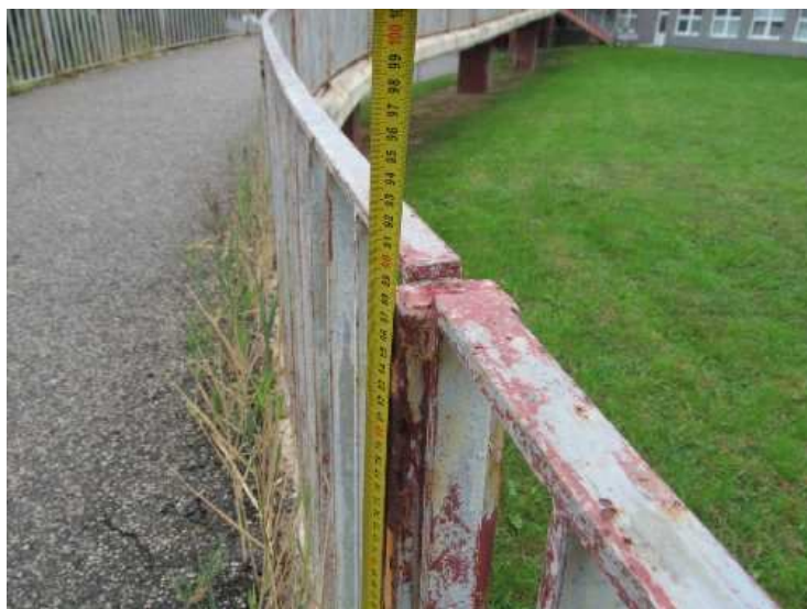
Výška zábradlí je pouze 0,9 m, neodpovídá dnes platné legislativě.
