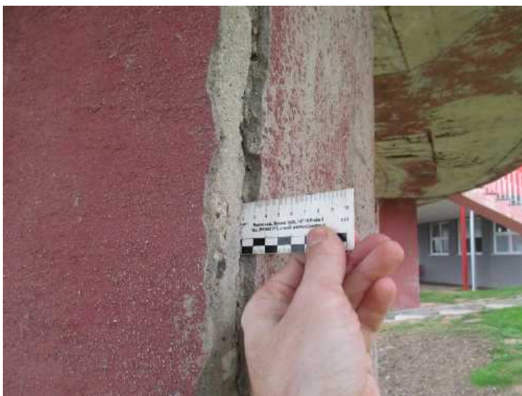
Trhlina na pravé straně pilíře Pi4.
