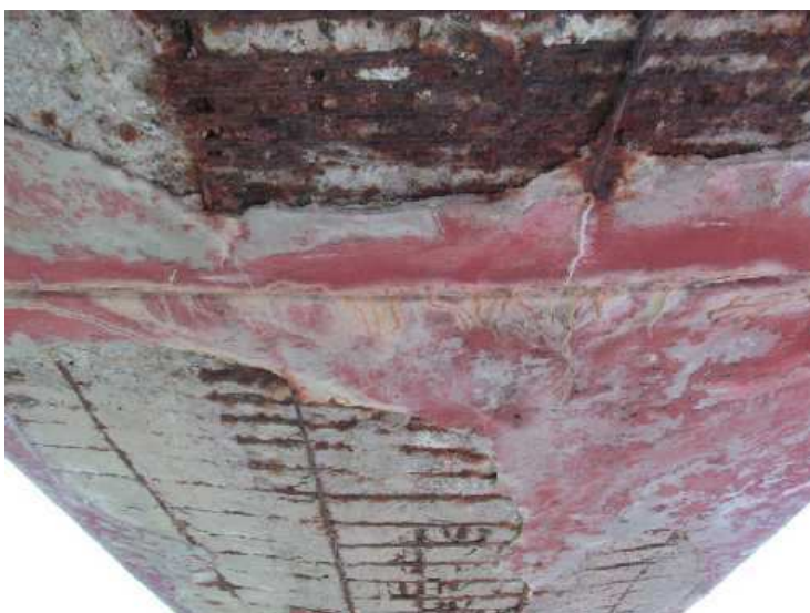
Výrazné průsaky a výluhy v pracovní spáře v poli 3.
