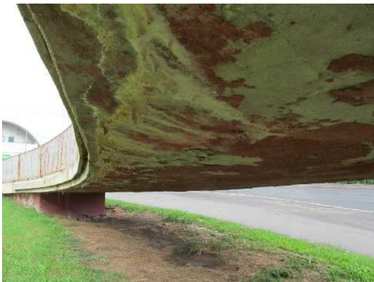
Pohled na opěru 1, silné výluhy na dolním líci, v tomto případě v poli 1.
