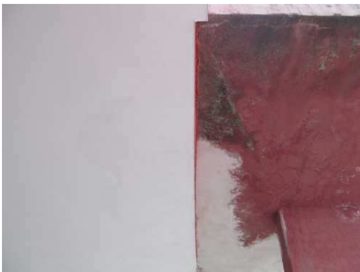
Vzlínání vody od spáry na dolním líci budovy pohotovosti.
