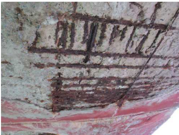
Obnažená silně korodující výztuž na dolním líci NK v poli 3.
