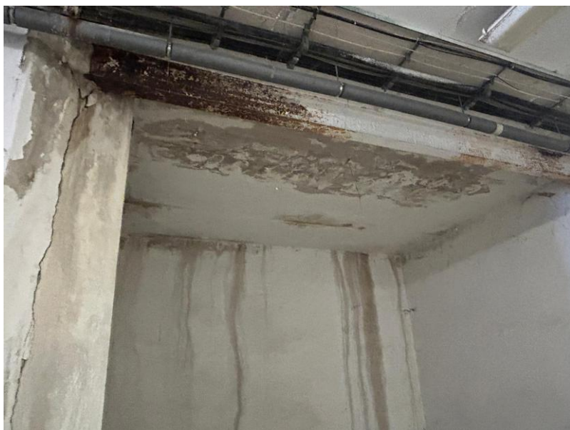
Stav u uložení sítí
