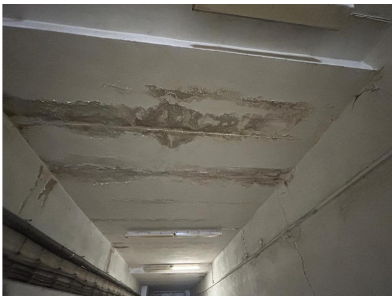
Pohled na strop kolektoru
