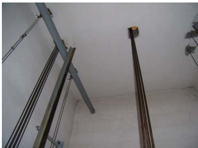
Vrchní část šachty
