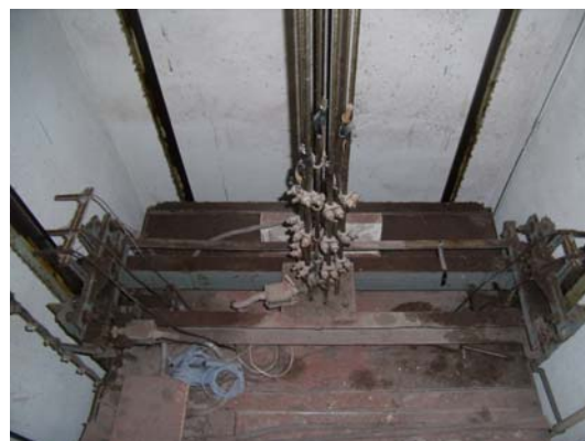
pohled strop kabiny
