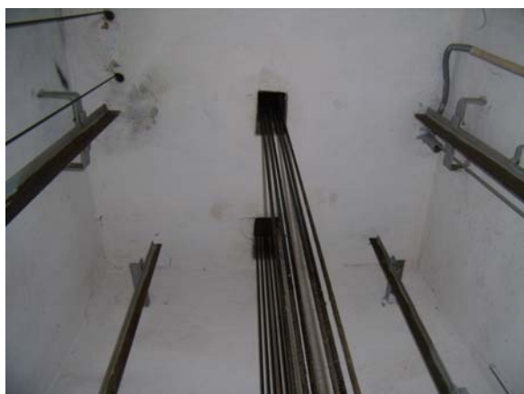
Vrchní část šachty
