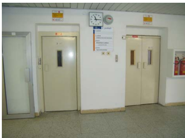
Nástupiště výtahu – vlevo výtah č.6
