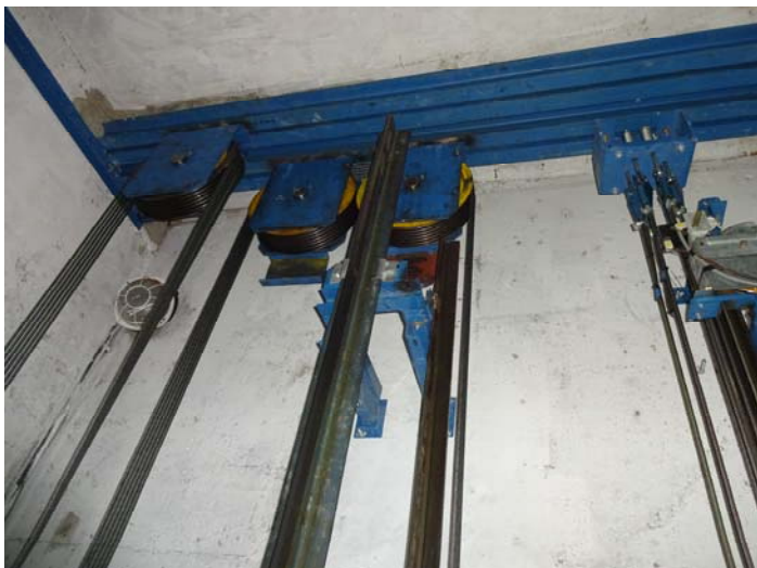
nosníky v hlavě šachty s kladkami a závěs
