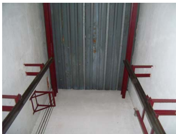
vršek šachty s montážními nosníky a odvětráním
