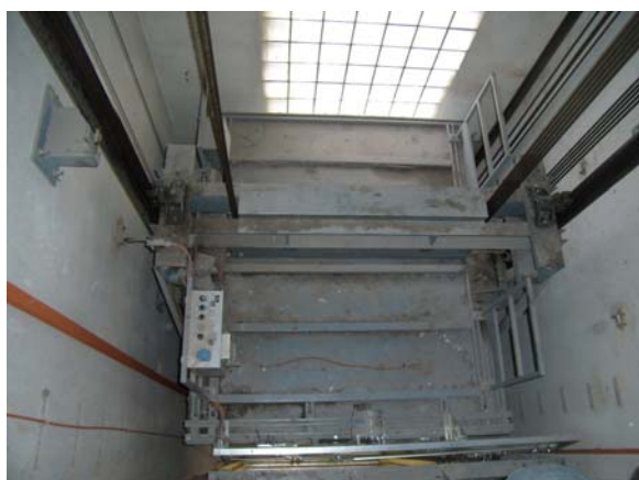
pohled do šachty
