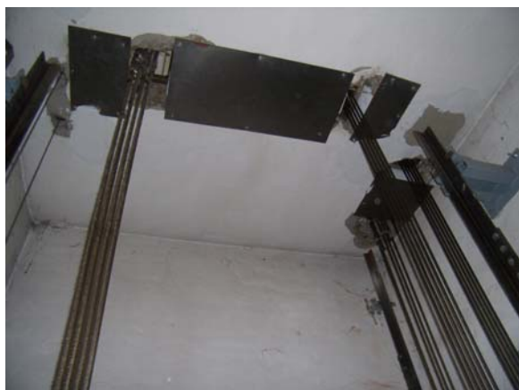
Vrchní část šachty
