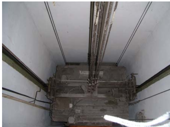
pohled do šachty výtahu
