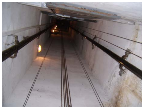
pohled do výtahové šachty
