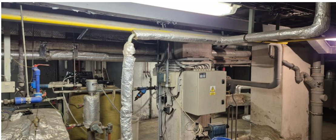
Oprava VZT potrubí, izolace, potrubí v suterénu pod kotelnou K2, atd.
