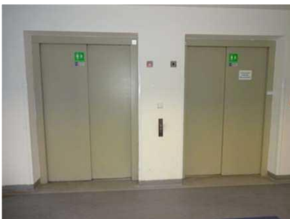
Pohled na nástupiště - výtah č.1 je vpravo
