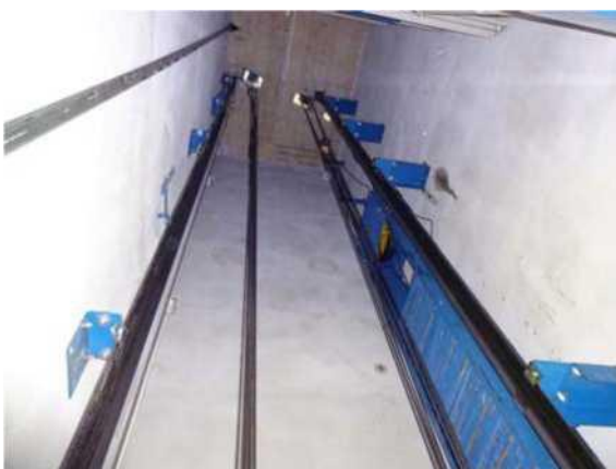
Pohled vzhůru do výtahové šachty
