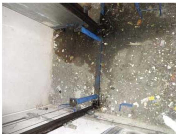
prohlubeň výtahové šachty
