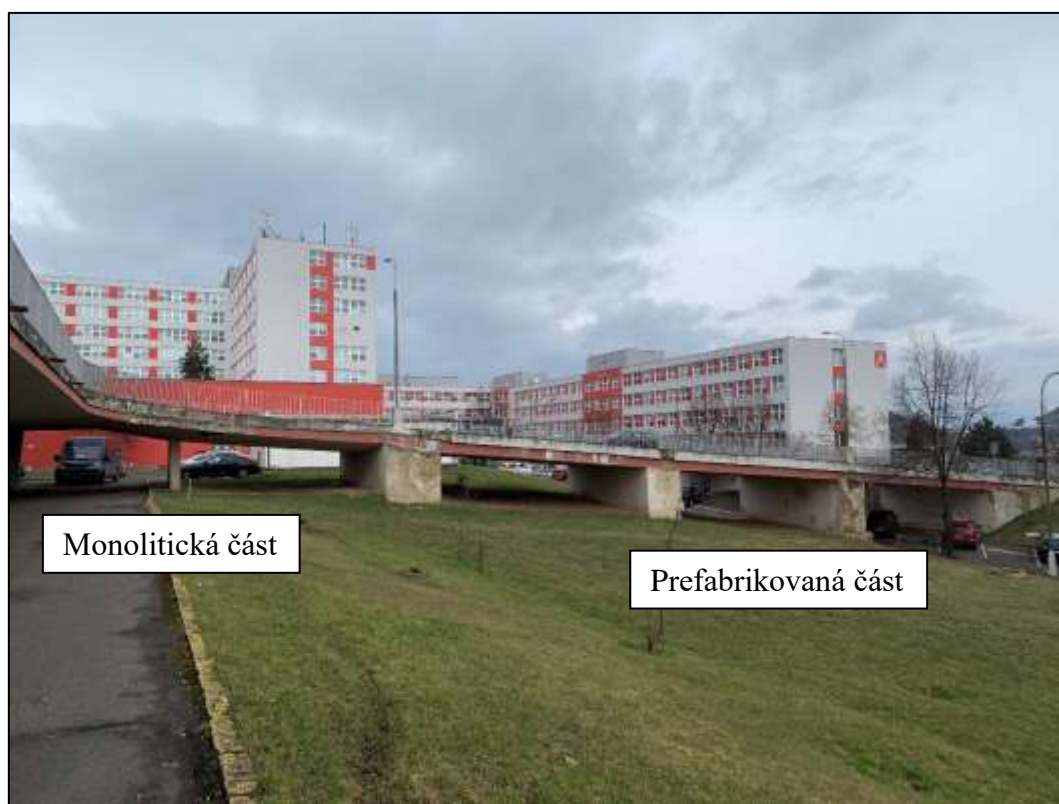
Foto 2: Celkový pohled na mostní objekt – převážně na prefabrikovanou část, pohled zleva
