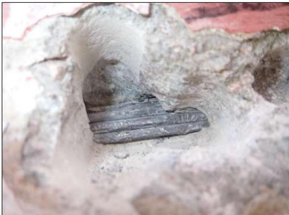
Foto 11: Detail sondy P11, předpínací výztuž, stěna nosníku č. 9, pole č. 2, poloha viz Příloha 1. Na předpínací výztuži nebyla nalezena koroze. Hodnocení korozního stavu přepínací výztuže: stupeň 1. Kanálek zcela vyplněn injektážní směsí. Krytí předpínací výztuže cca 45 mm.
