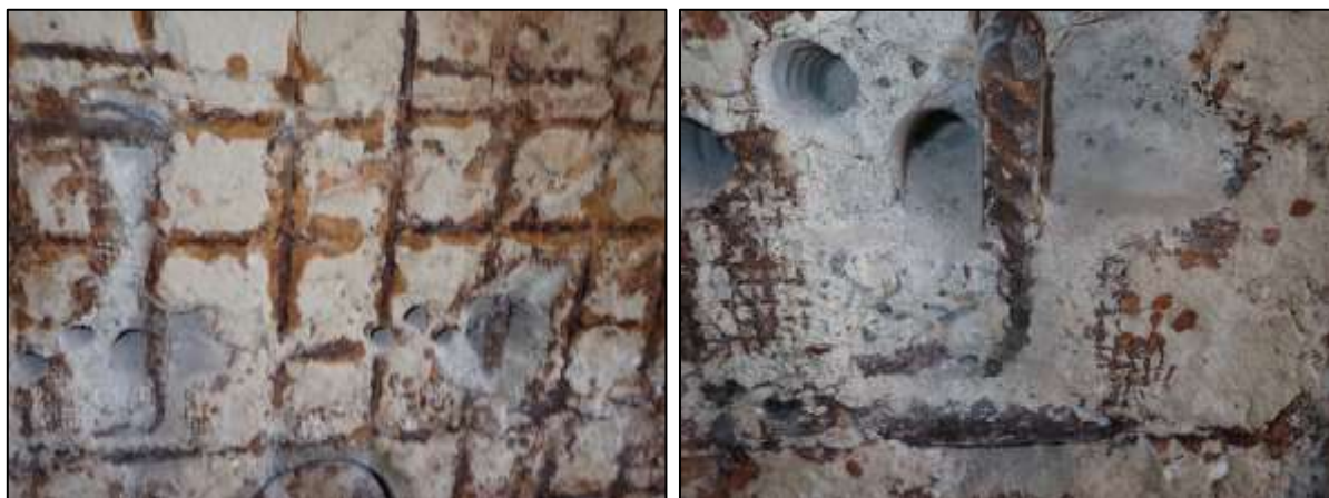
Foto 25: Detail sondy S5, prefabrikovaná část – pilíř, poloha viz Příloha 1. Svislá a vodorovná výztuž. Povrchová koroze (P) s oslabením plochy průřezu do 5 %. Nesoudržná vrstva sanace (opadává), korodující pletivo a KARI síť.
