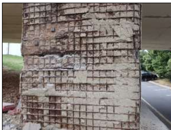
Foto 25: Detail sondy S5, prefabrikovaná část – pilíř, poloha viz Příloha 1. Svislá a vodorovná výztuž. Povrchová koroze (P) s oslabením plochy průřezu do 5 %. Nesoudržná vrstva sanace (opadává), korodující pletivo a KARI síť.
