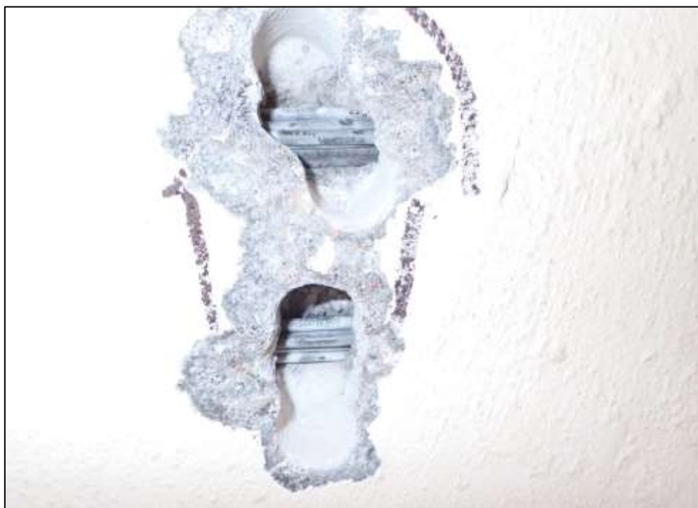
Foto 14: Detail sondy P14, předpínací výztuž, spodní líc nosníku č. 2, pole č. 1, poloha viz Příloha 1. Na předpínací výztuži byla nalezena koroze. Hodnocení korozního stavu předpínací výztuže: stupeň 2. Kanálek zcela vyplněn injektážní směsí. Krytí předpínací výztuže cca 25 mm.
