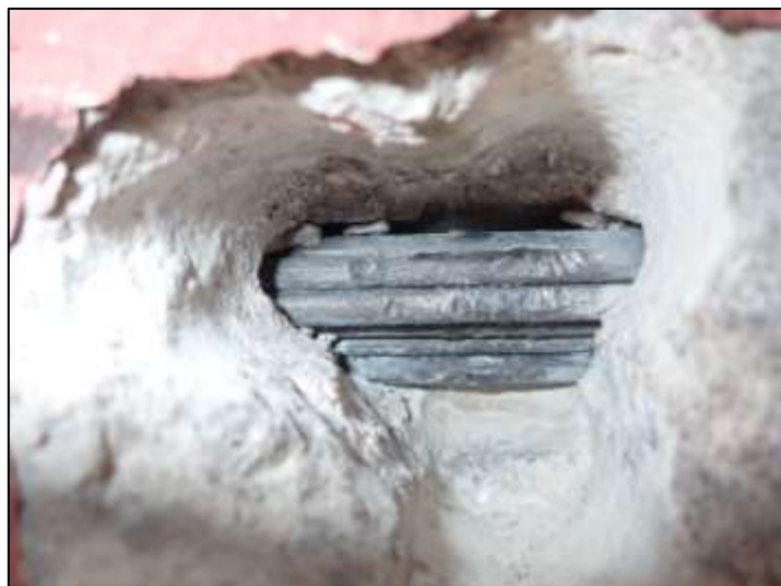
Foto 1: Detail sondy P1, předpínací výztuž, stěna nosníku č. 1, pole č. 3, poloha viz Příloha 1. Na předpínací výztuži nebyla nalezena koroze. Hodnocení korozního stavu přepínací výztuže: stupeň 1. Kanálek vyplněn injektážní směsí částečně. Krytí předpínací výztuže cca 40 mm.
