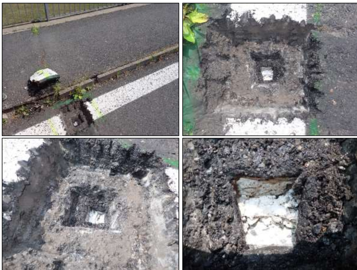
Foto 33: Detail sondy S13, styk KA nosníků nad pilířem, mezi polem 2 a 3. Po odstranění hydroizolace nebyla v místě sondy patrná vlhkost.
