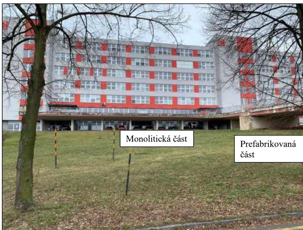
Foto 1: Celkový pohled na mostní objekt – převážně na monolitickou část., pohled zleva
