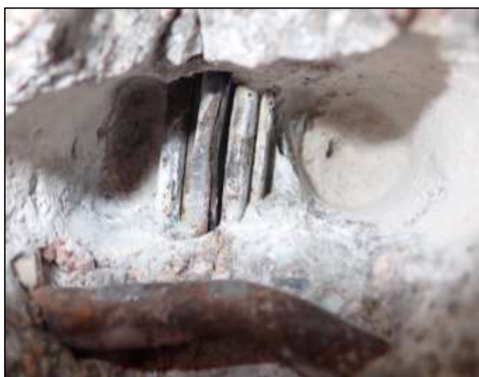
Foto 4: Detail sondy P4, předpínací výztuž, spodní líc nosníku č. 5, pole č. 3, poloha viz Příloha 1. Na předpínací výztuži byla nalezena korozí. Hodnocení korozního stavu předpínací výztuže: stupeň 3. Kanálek vyplněn injektážní směsí částečně. Krytí předpínací výztuže cca 35 mm.
