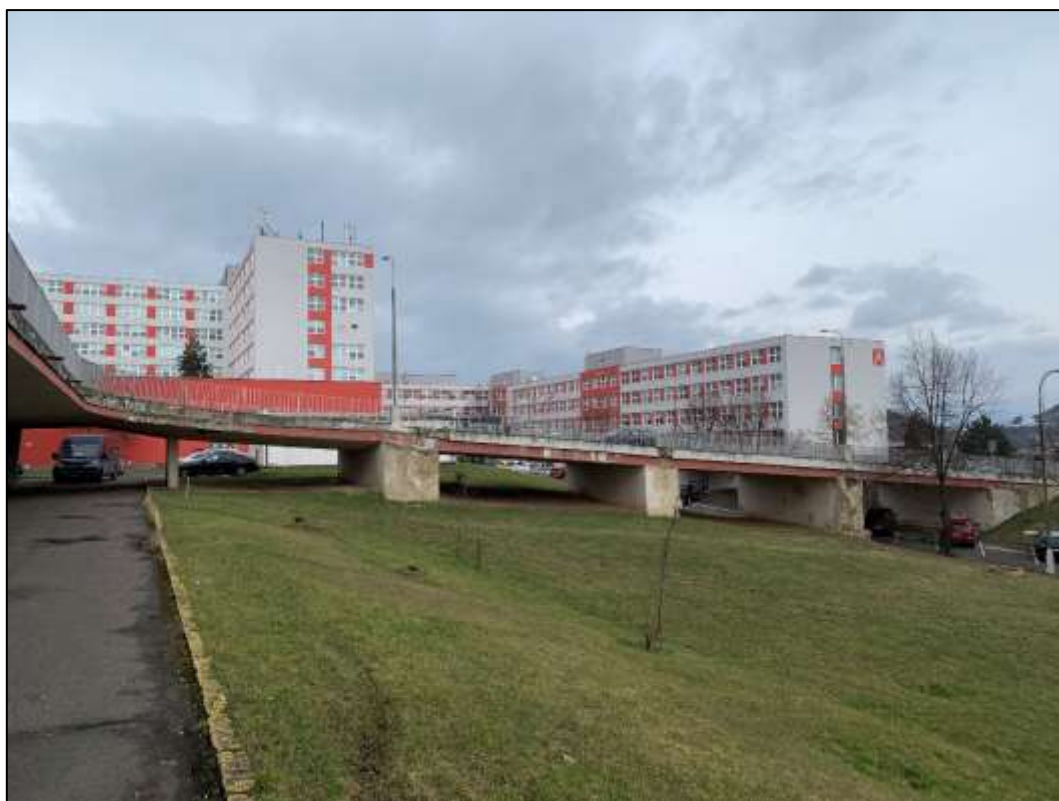
Foto. 1: Pohled na část mostní konstrukce k budově „C“
