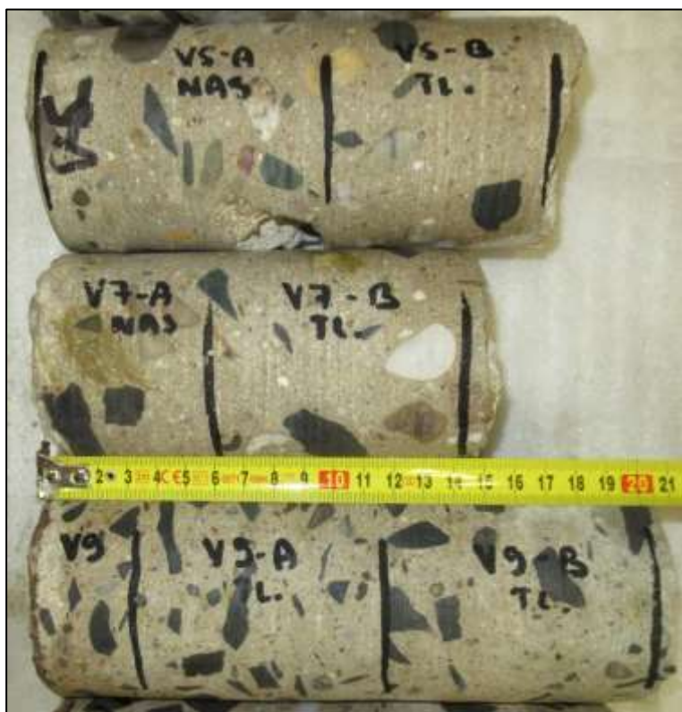
Foto 4: Pohled na vývrty V5, V7 a V9
