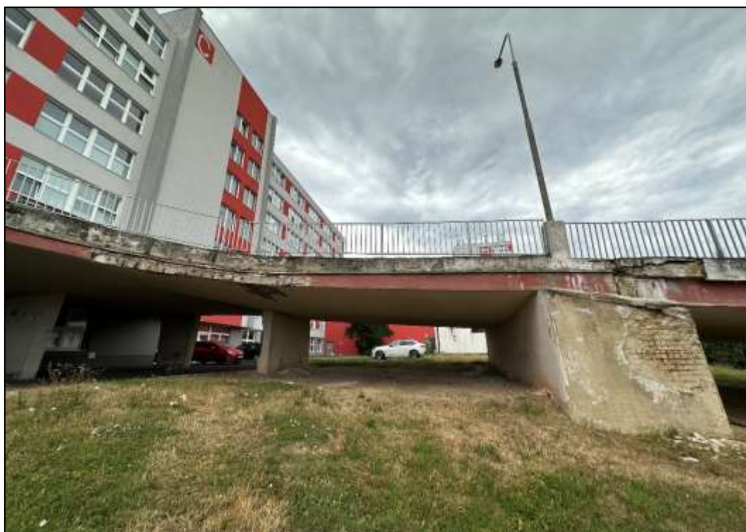
Foto 23: Monolitická část - Nájezd v oblasti dilatace, pohled zleva, patrné stopy po zatékání a akusticky zřejmá nesoudržná krycí vrstva betonu – částečně již opadaná, koroze obnažené betonářské výztuže NK
