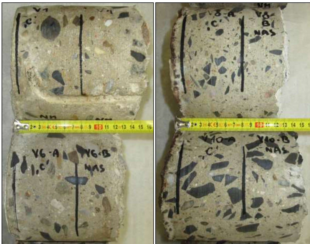
Foto 1: Pohled na vývrty V1, V6, V8 a V10
