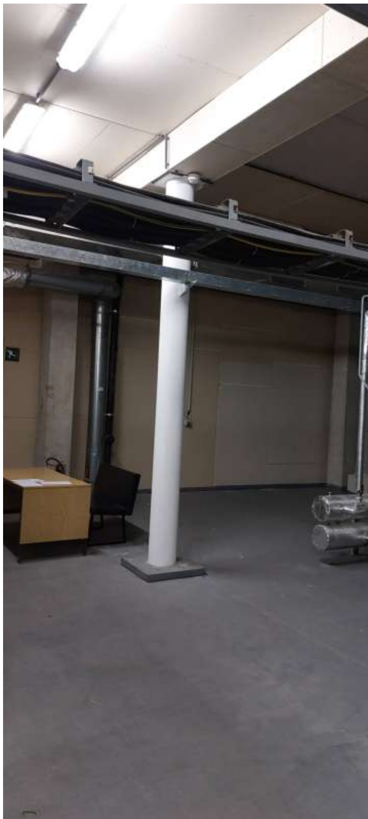
Obr. 29: Doplnované ocelové sloupy Tr 273x8 v podlaží pod heliportem
