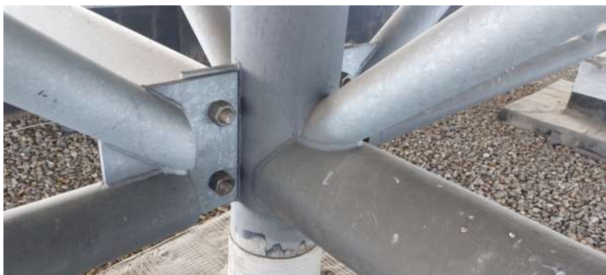
Obr. 14: Detail přírubového šroubovaného styku 2 x M 24 (8.8) u dolního styku příhradového zavětrování. Bez staticky významné koroze, Změřená tloušťka v daném místě byla 500 \mu m.
