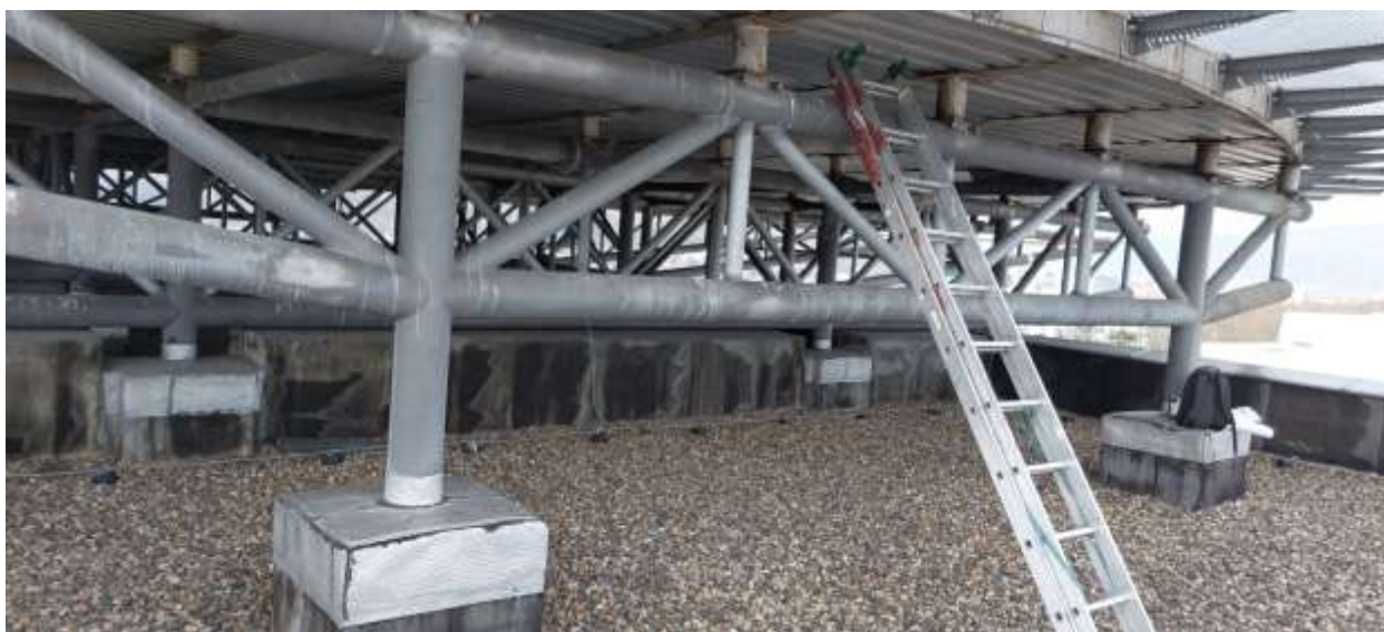
Obr. 5: Ocelová konstrukce - krajní vazník bez přířubového styku s příčnými stabilizačními distancemi
