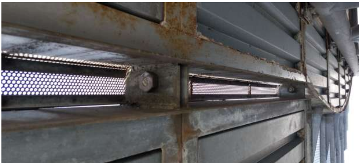
Obr. 25: Šroubové napojení lávky na heliport
