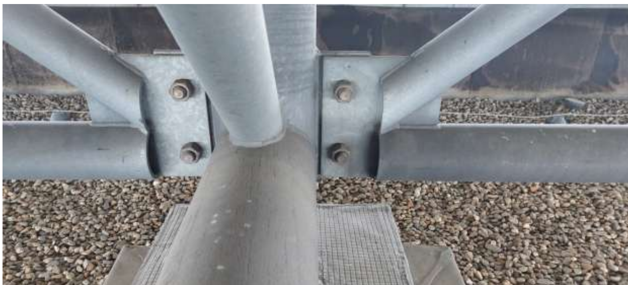
Obr. 15: Detail přírubového šroubovaného styku 2 x M 24 (8.8) u dolního styku příhradového zavětrování. Bez staticky významné koroze, Změřená tloušťka v daném místě byla 500 \mu m.
