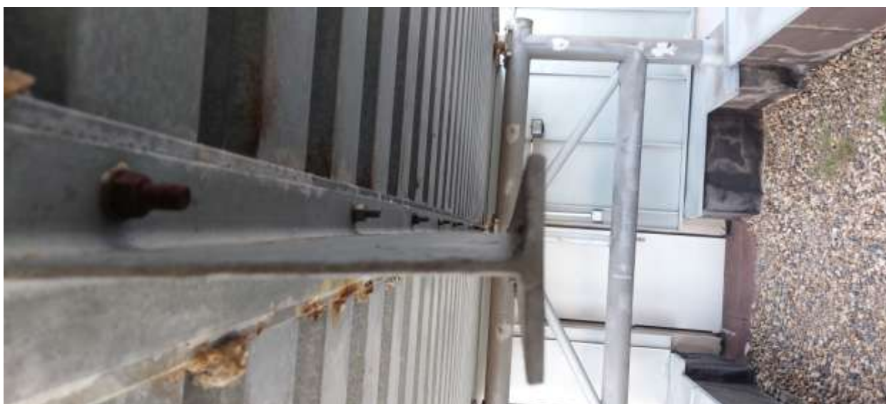
Obr. 24: Zesílení pomocí IPE pod spodní přírubou lávky.
