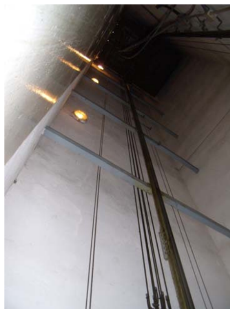
pohled do šachty
