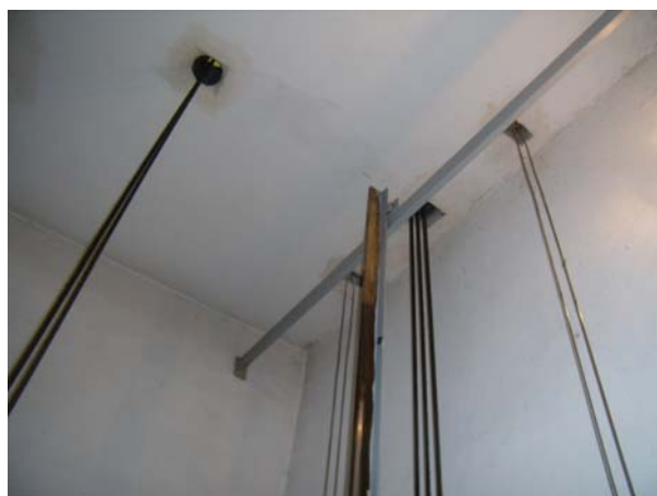
vrchní část šachty
