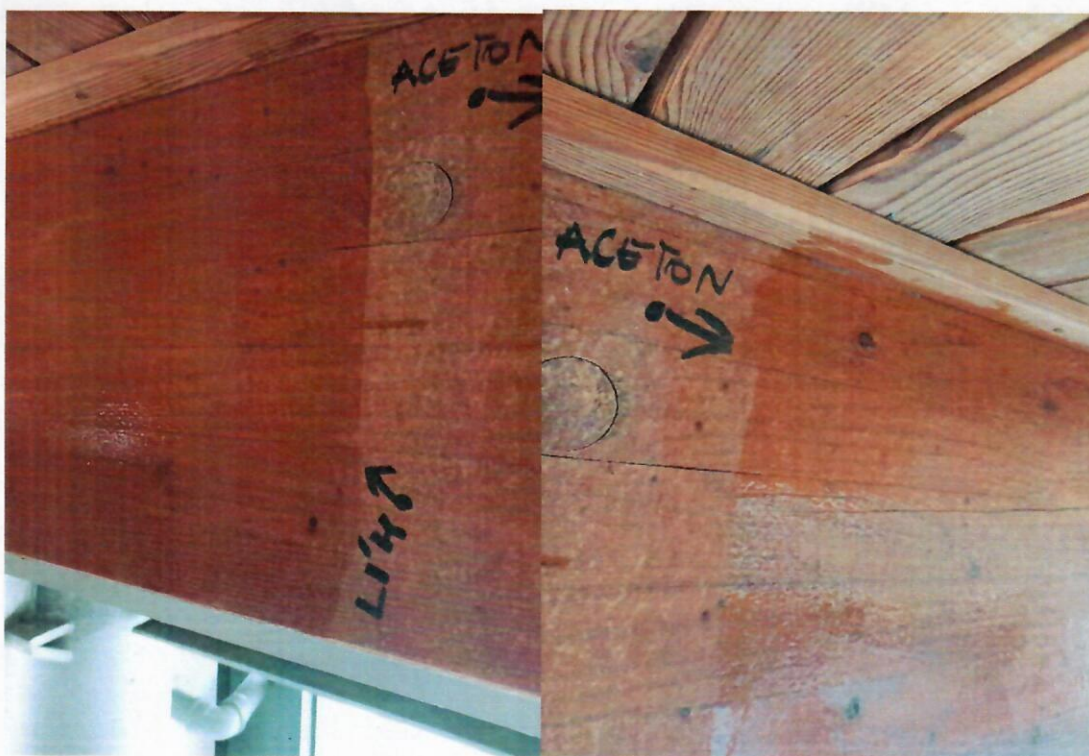
Odmaštění lihem, zdrsnění a vlastní aplikace Odmaštění acetonem, zdrsnění a vlastní aplikace
