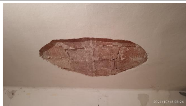
Obr.6 - Detail konstrukce stropu (pro všechna podlaží)
