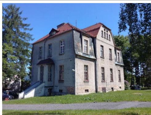
Obr.2 - Budova HTO z jihu
