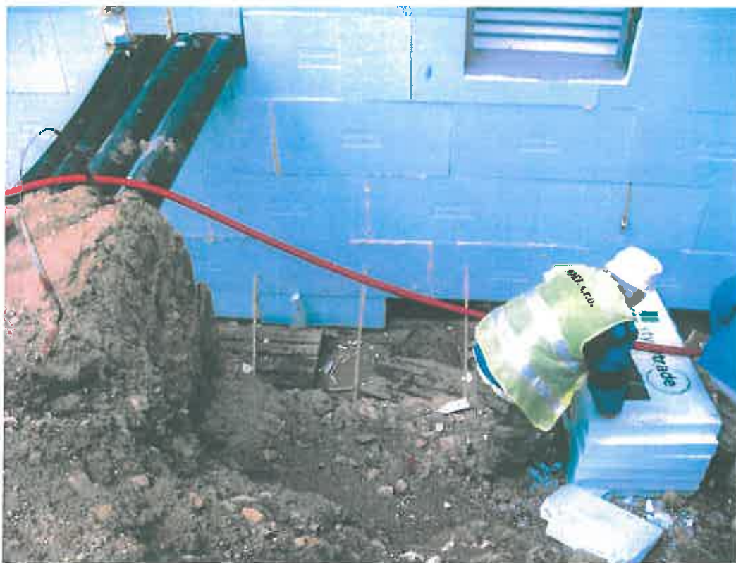
I.PP – střední část – zateplení, výkop pro drenáž
