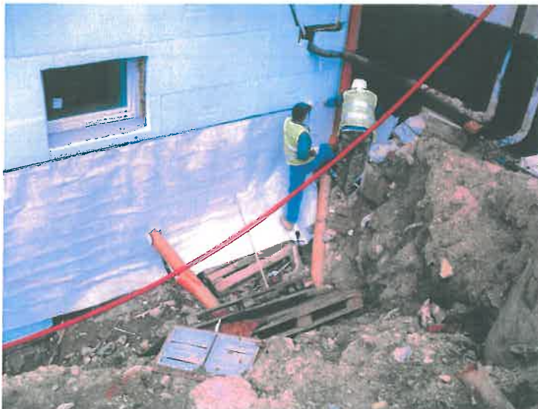
I.PP – střední část – zateplení, výkop pro drenáž, izolace
