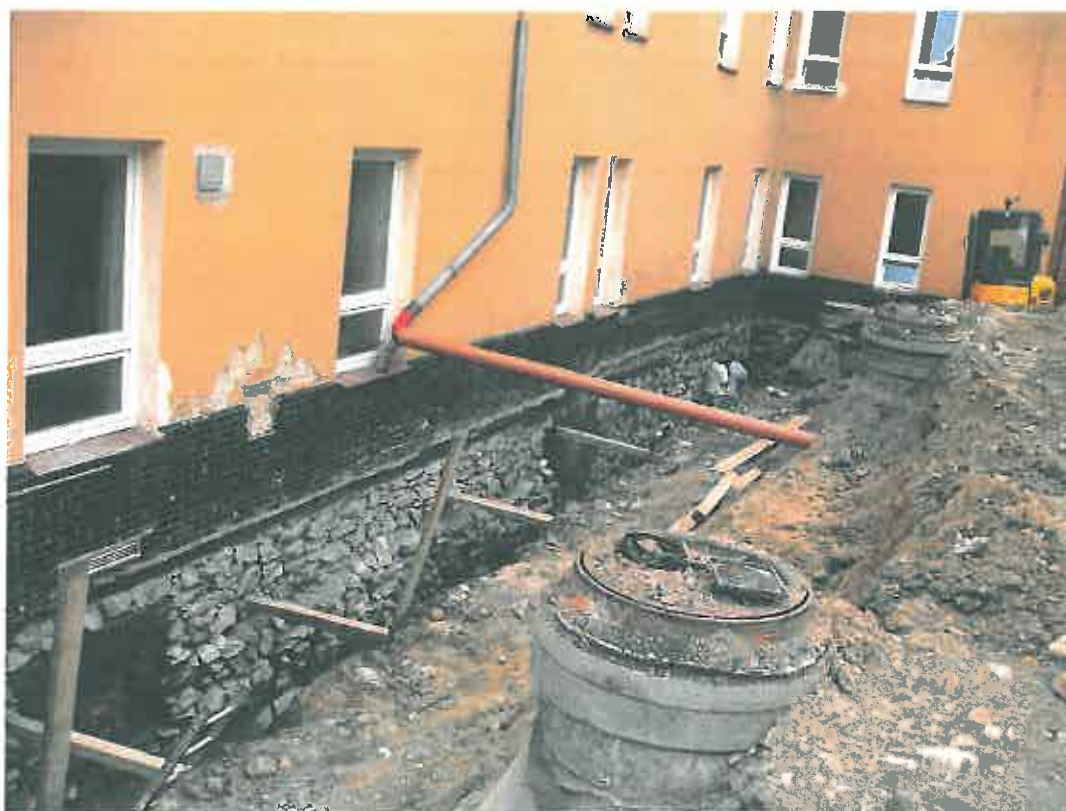
POHLED NA STÁVAJÍCÍ ZÁKLADY, ZAZDÍVKA PŮVODNÍCH ANGLICKÝCH DVORKŮ
